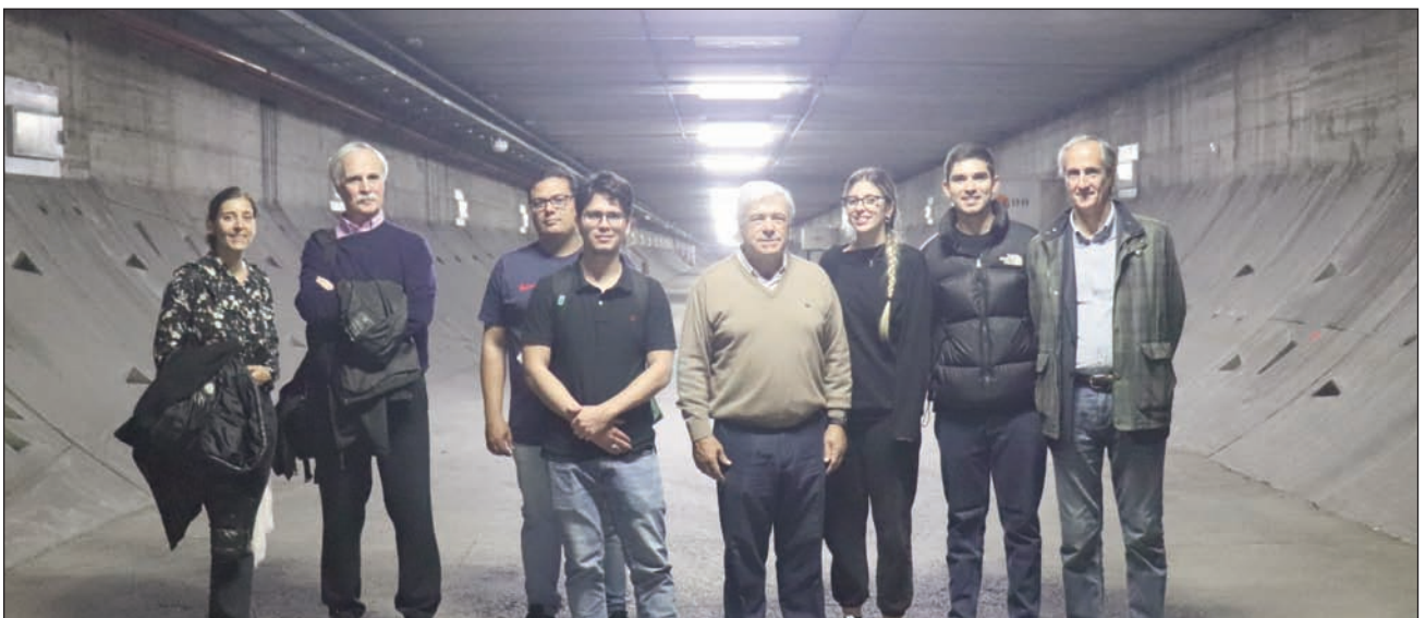
Algunos de los asistentes a esta visita en las galerías de emergencia de la los túneles del bypass de la M-30
