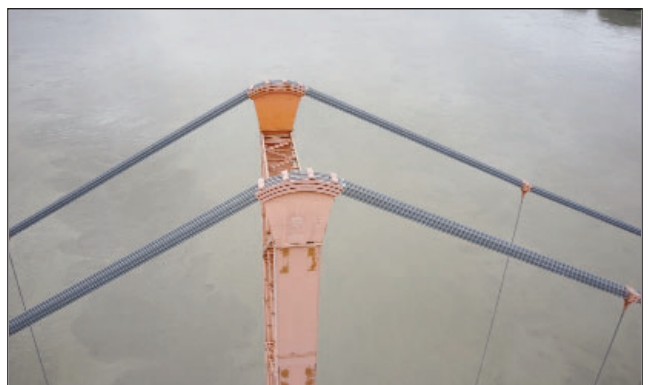
Sillas de cambio inspeccionadas
