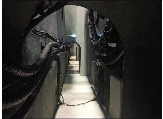
Las galerías subterráneas abiertas a visitas por primera vez
